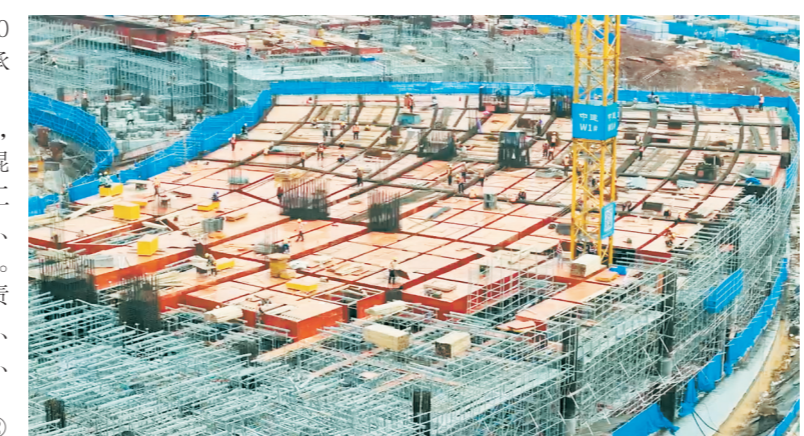
扫码看辣视频 长沙奥体中心主体育场冲刺封顶 “五一”假期，长沙奥体中心项目建设现场一片繁忙。长沙晚报通讯员 曹梦然 供图
