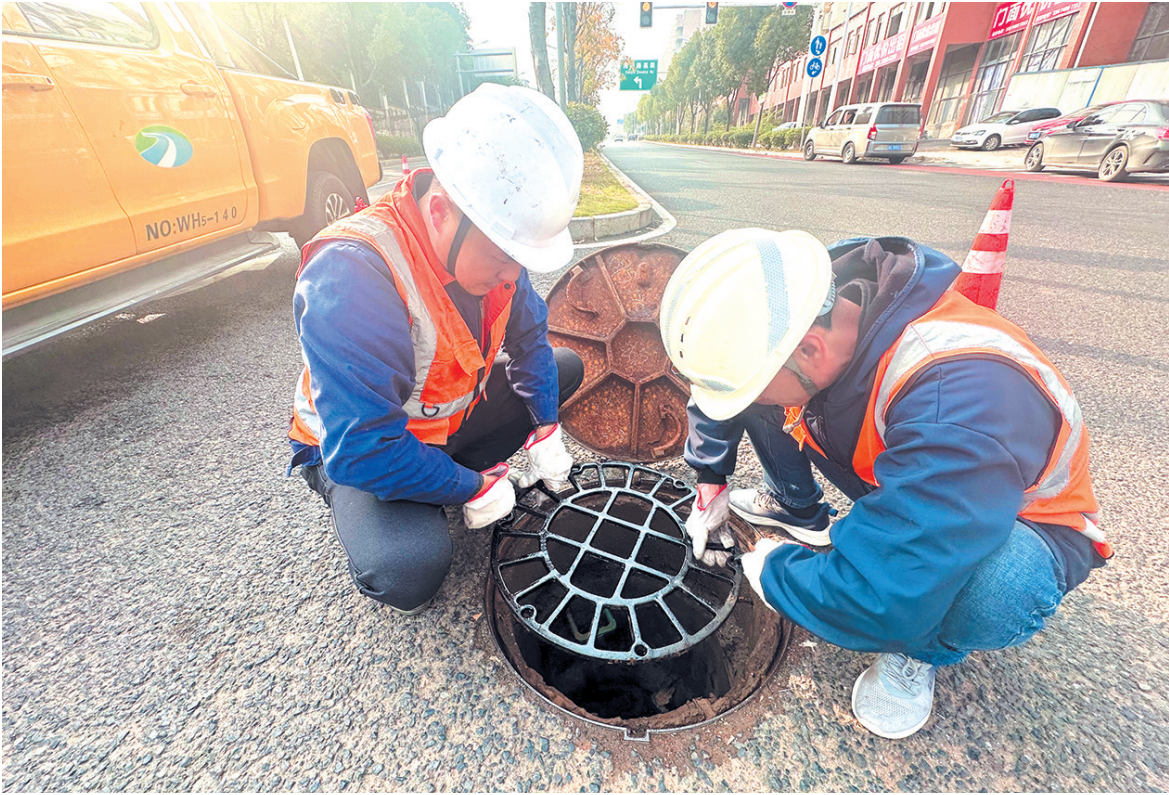
如今安装的全全球墨铸铁材质防坠网承重提升到1吨以上，而且防腐防潮，安装后不易脱落，耐用性大幅提高。 长沙晚报全媒体记者 周游 通讯员 高兴 摄影报道
