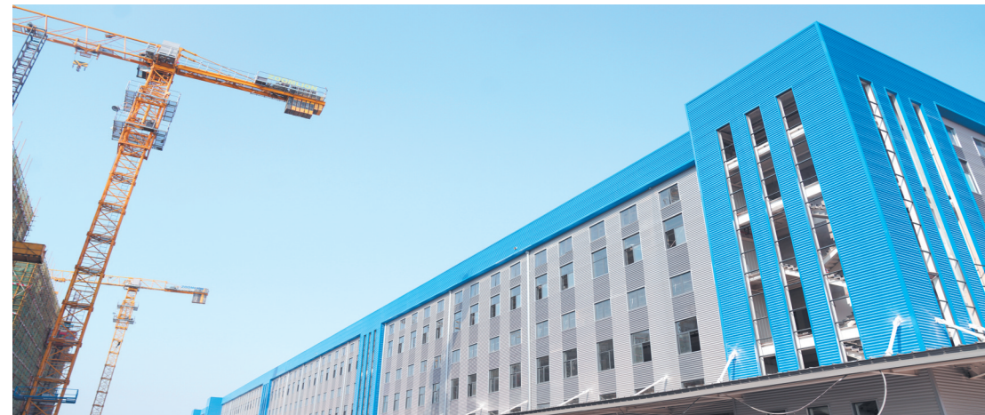
中通跨境智能物流产业园项目主体结构已封顶。长沙晚报通讯员 常柯 供图
